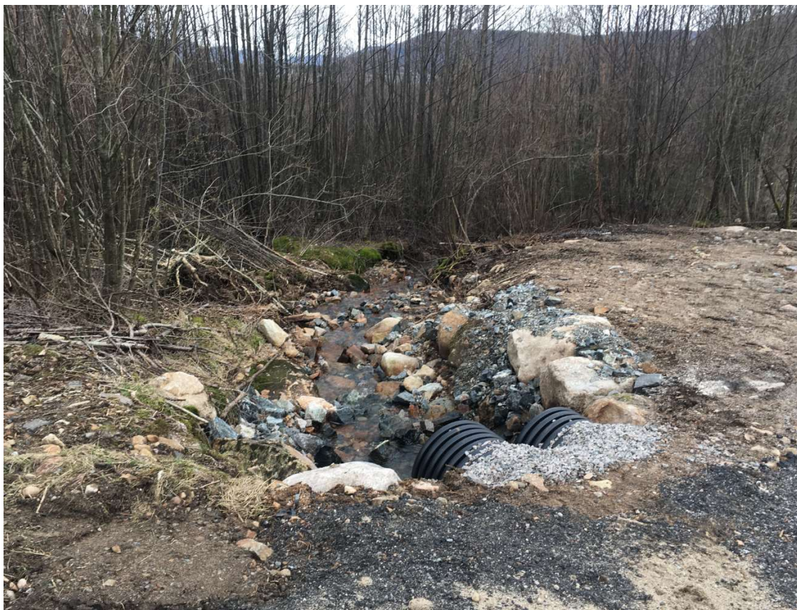
Fig 4 Utløp av dagens overvannskulvert gjennom Ringveien til OV2.
